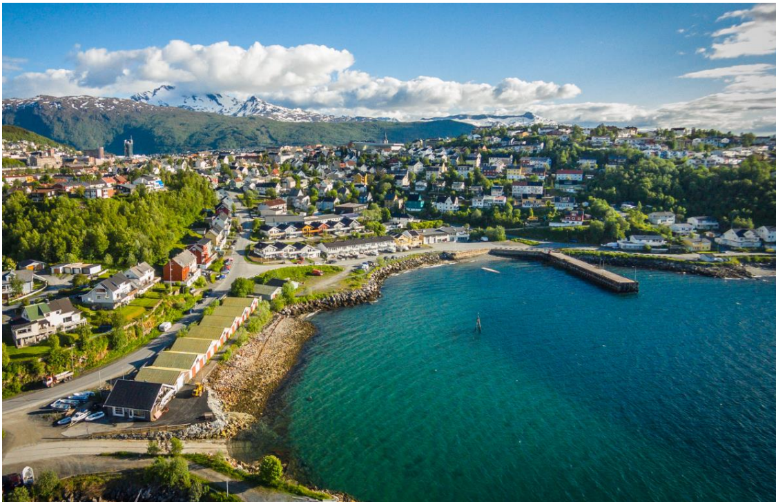
Bilde 3: Flyfoto av området for boliger i øst, retning sør.
