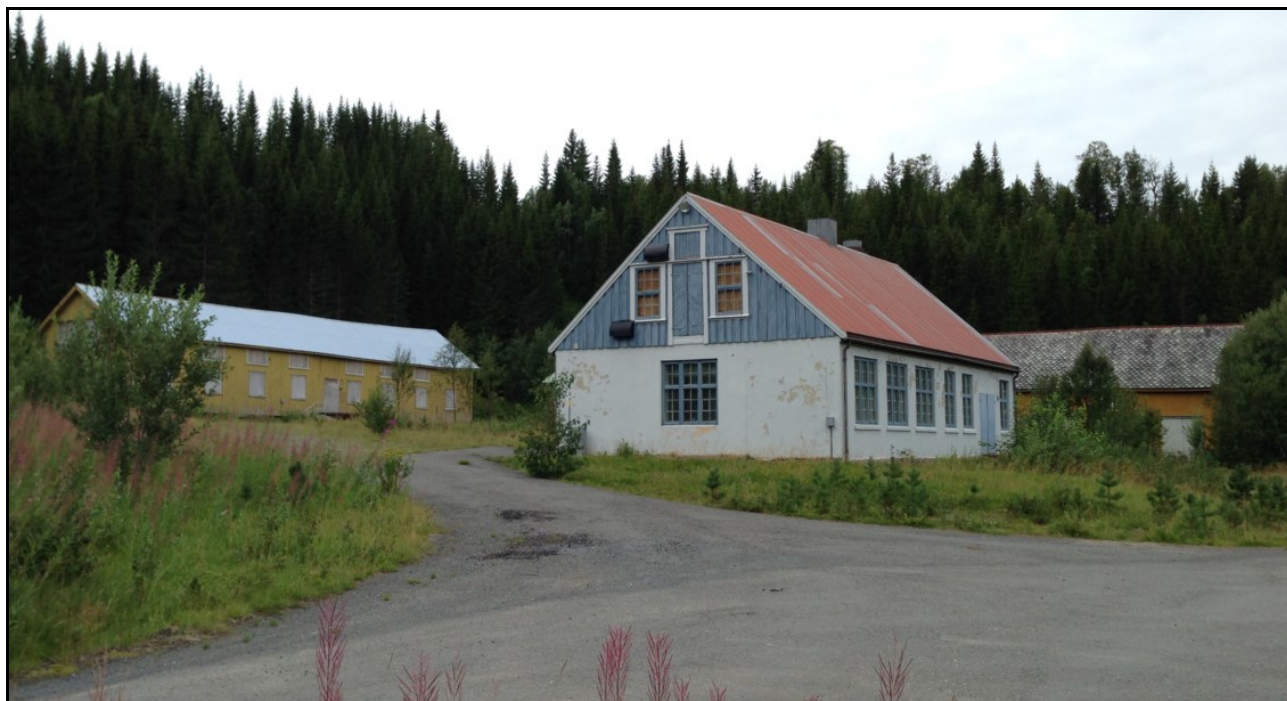
Figur 9. Stordalen. Bygninger fra 1909-1921.
