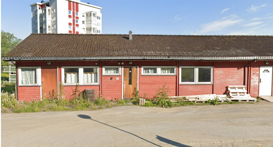
Figur 10 Utklipp fra Google Maps som viser eksisterende bygning i tiltaksområdet, og at takvann ledes i takrenner som går ned i bakken.
