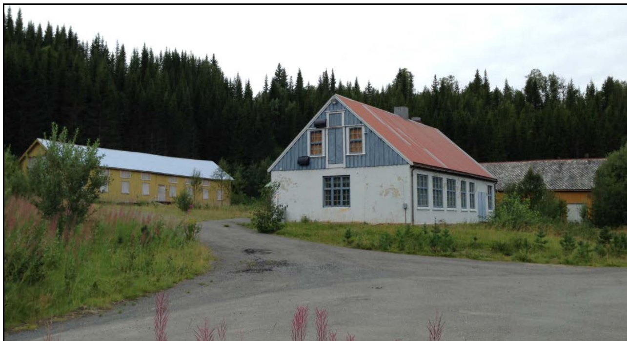
Figur 9. Stordalen. Bygninger fra 1909-1921.
