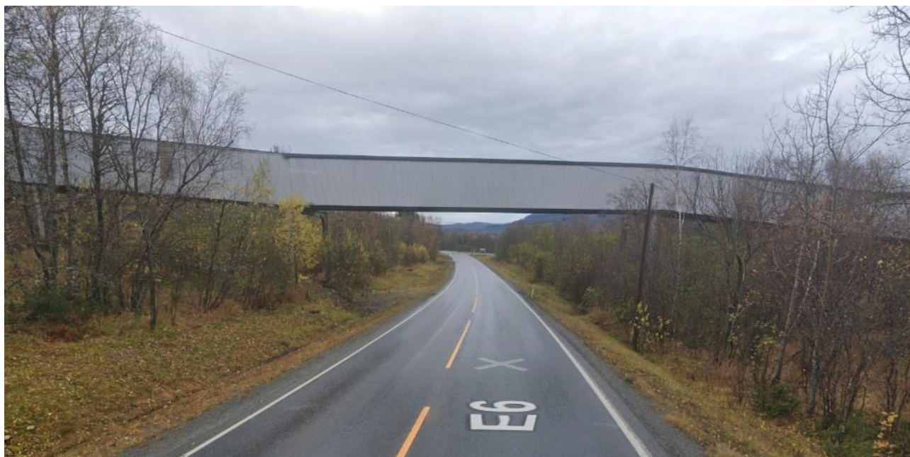
Figur 4-7 Transportbånd mellom Arnesfjellet industriområdet og Fornes som krysser E6. Bilde fra Google Maps, Streetview.
