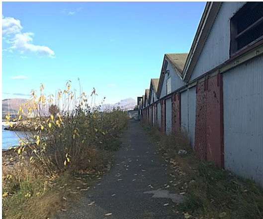
Tursti langs eksisterende naust i øst er lett tilgjengelig og har relativt god framkommelighet for alle brukergrupper.
