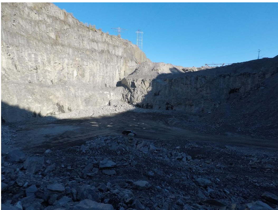
Figur 5 - Plassering av mast og ledning i forhold til dagens brudd.
