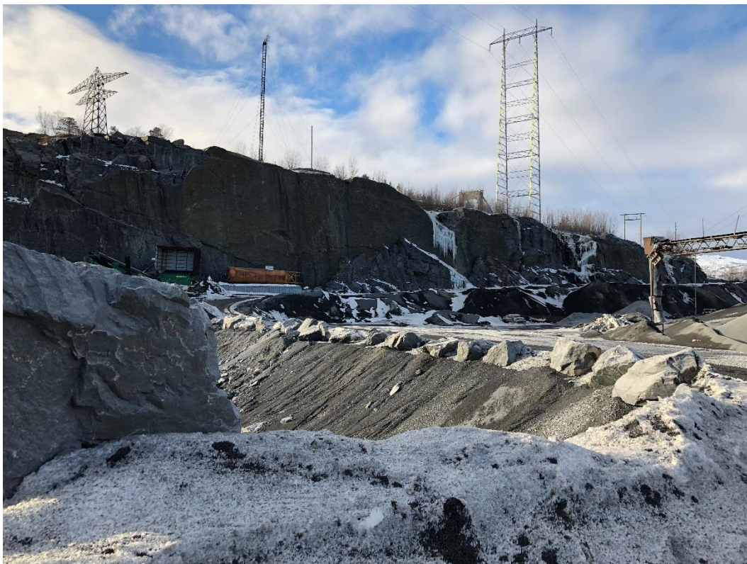
Figur 4 - Mast på transmisjonsnettledning
