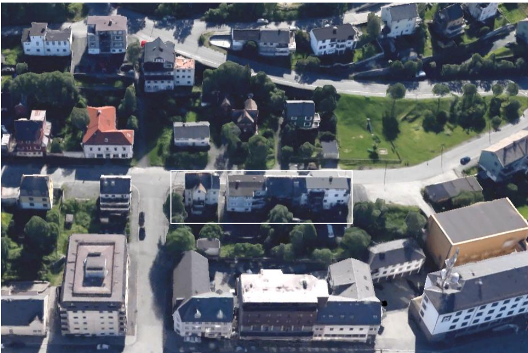
Figur 1: Dagens situasjon, retning mot sør. De to byggene til venstre innenfor markeringen skal erstattes med ett nytt leilighetsbygg. Kilde: Google Earth.
