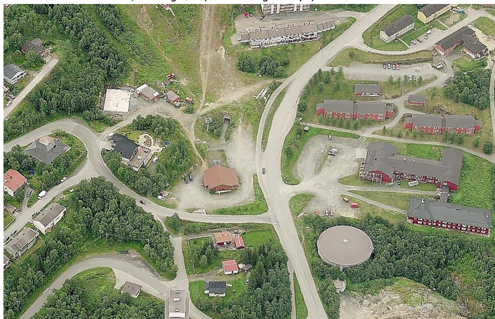
Bilde 5-1: Oversiktsbilde, retning sør. (Kilde: Google Maps)
