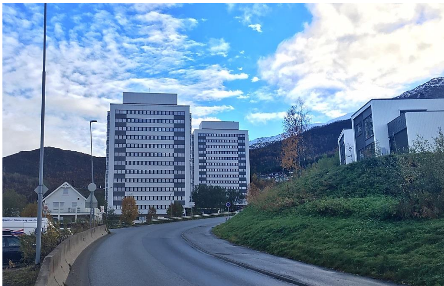
Bilde 5-3: Eksisterende høyblokker nord for planområdet
