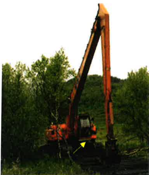
NVE anleggs «Langemann» ble brukt under gravearbeidet i Børselva. Legg merke til personen på bildet, for å få et inntrykk av grave-armens lengde. (Foto: K. J. Aanes)
