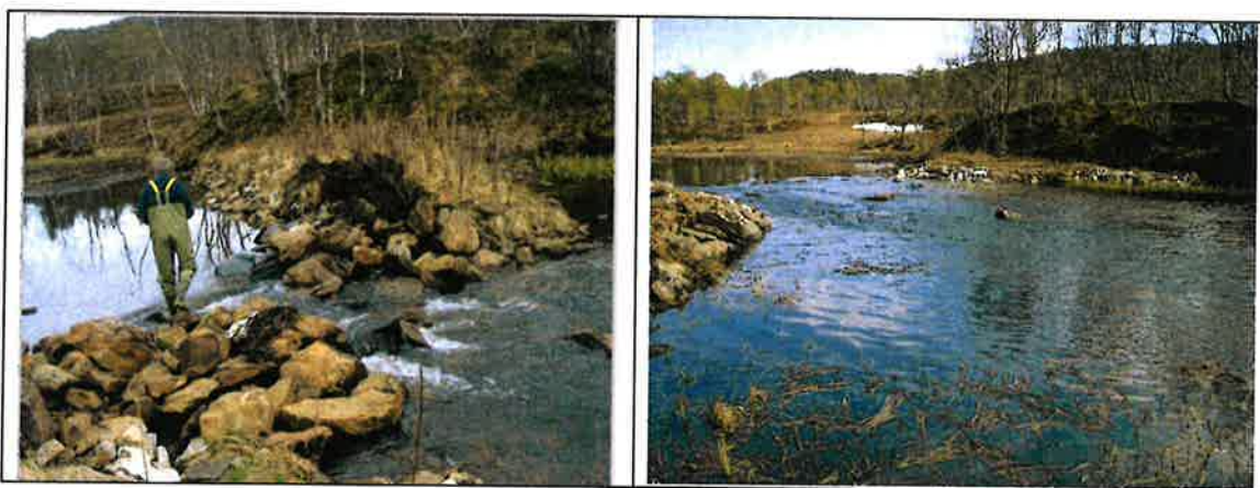
Nedre terskel ved Ivarsmyr . Til venstre midlertidig terskel anlagt i forbindelse med flåtearbeider. Til høyre etter at den ble reetablert (Foto: K. J. Aanes)
