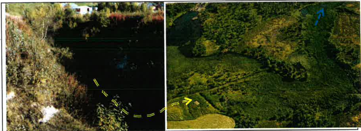
Erosjon i jordbrukskanalen og transport av finstoff ut i Børselva ga store avsetninger som fylte opp elveleiet nedstrøms og flere partier lengre nede (Foto før tiltak).
