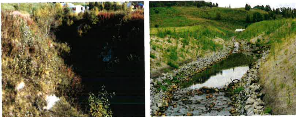
Figur 2. «Jordbrukskanalen» fra Bruksåsmoen før og etter at tiltak ble gjennomført for å stoppe erosjon og slamtransport fra denne til Børselva (Foto: K. J. Aanes). Se også foto i vedlegg D. I utgangspunktet var denne kanalen 1 m dyp og 2 m bred.
