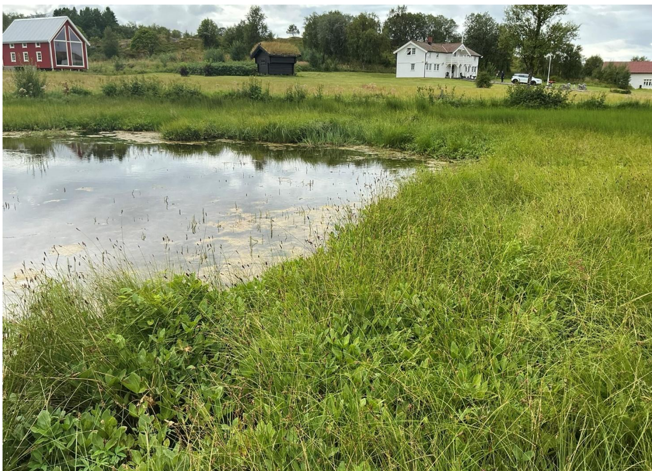
Figur 3-8: Foto av den opparbeidede dammen i nordlig del av våtdraget (delområde 6).
