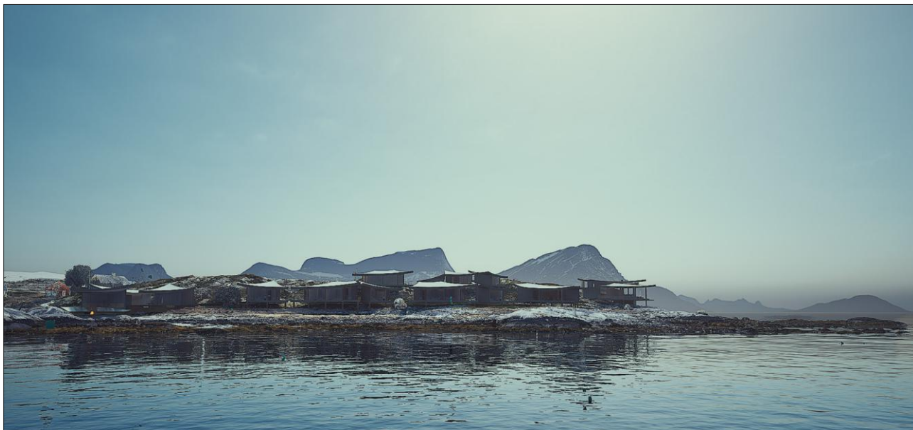
Figur 6 Tiltaket sett i retning sør, med Josefinahuset til venstre. Kilde: Snøhetta
