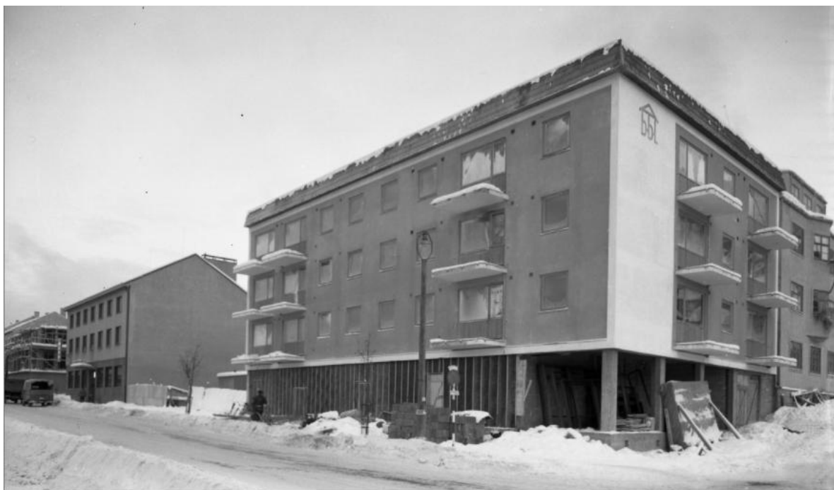
Bilde 4: Kongens gate 24 og Kongens gate 20 nærmest 4
