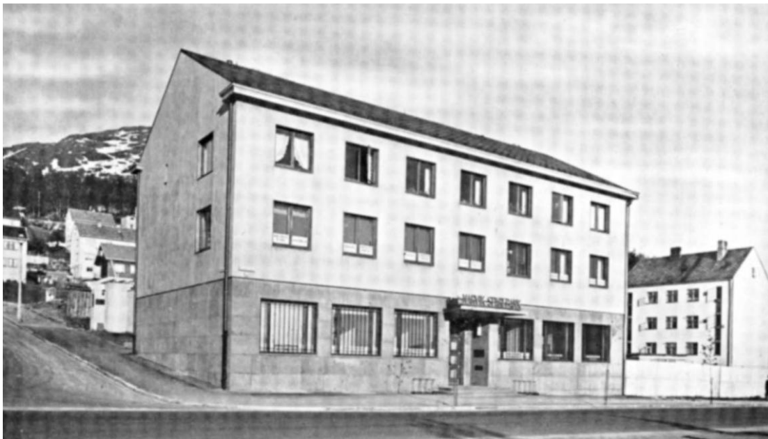
Bilde 1: Kongens gate 24, Breibakken 1 til høyre. Fotografert ca. 1950. 15
