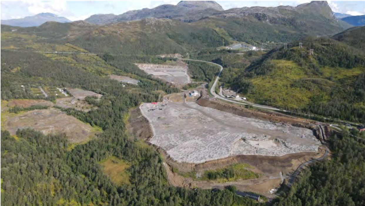
Figur 1-3: Skoglund – dagens situasjon. Dronefoto som viser gjennomførte anleggstekniske grunnarbeider. Foto: Aker Narvik.
