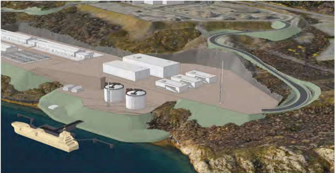
Figur 5-9: Planlagt industriområde ved Lallasletta. I modellen er lagringstankene plassert på ca. kote +15. Øvrig anlegg er plassert på ca. kote +30 og +35. Til sammenligning ligger Herjangshøgda næringsområde rundt kote +86.
