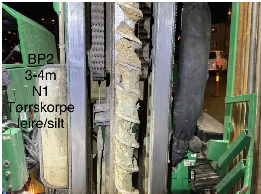
Figur 3-1: Naverboring gjennomført på dybde 3-4 m i borpunkt BP2.
