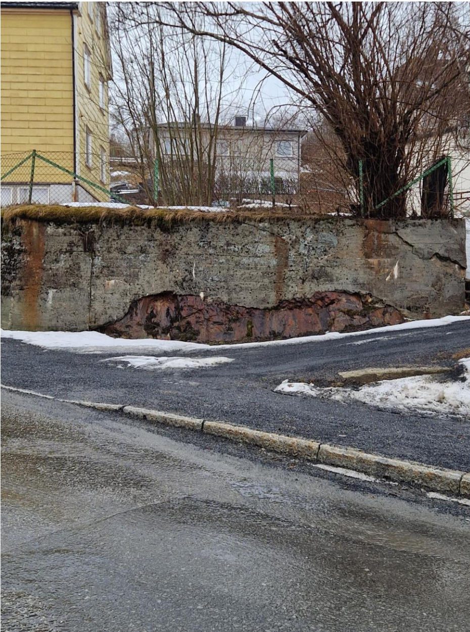
Bilde 5. Antatt berg i dagen ved Diagonalgata 41.
