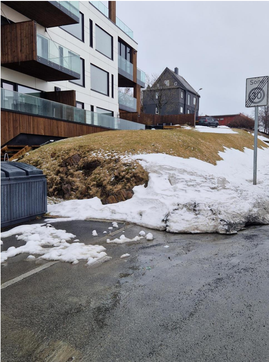
Bilde 4. Antatt berg i dagen i Tore Hunds gate 34/45. Boligblokk står på utsprengt berg.
