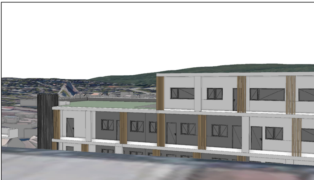
Figur 22: Utsikt fra takterrasse i femte etasje Tore Hunds gate 34, retning vestnordvest. Siktklinje 1. Kilde: Sweco/Hamperokken Arkitektur AS.
