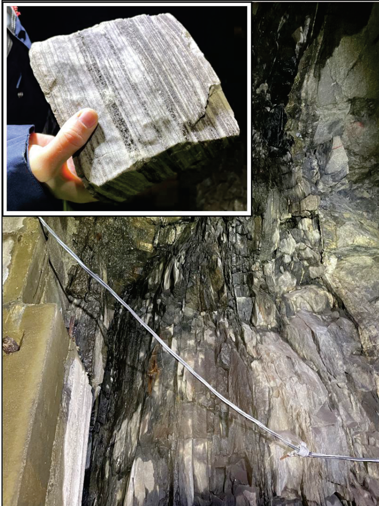
Figur 4.10 En forkastning er studert i tunnel ved Katterat stasjon og vurderes å være tilknyttet Rombak–Skjomen skjærsonen med nord–sør-orientering. Sonen er preget av tettere oppsprekking enn omkringliggende bergmasse. Bergarten er omdannet til mylonitt (forkastningsbergart).
