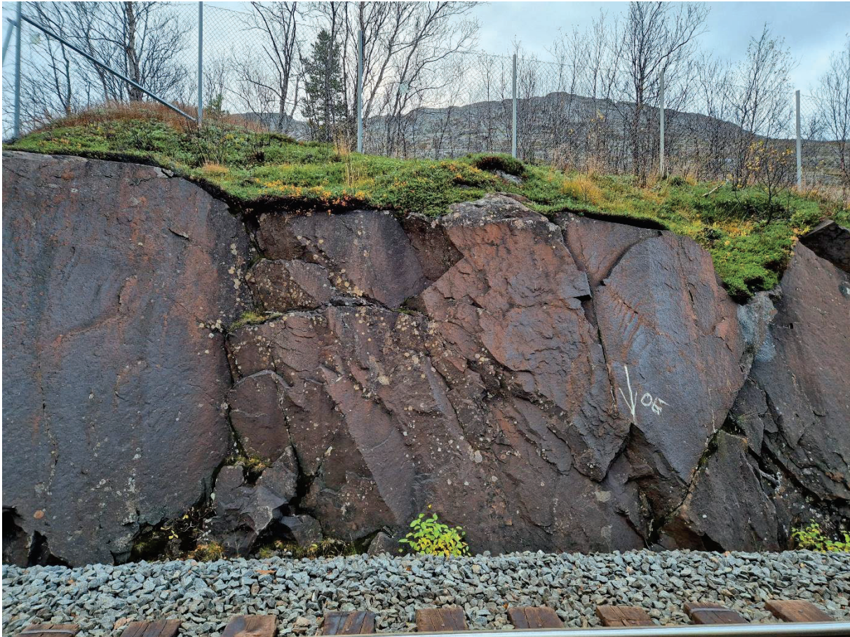
Figur 4.11 Eksempelbilde langs trase i nærheten av påhugg sør. Bergmassen består av granitt og vurderes generelt som god.
