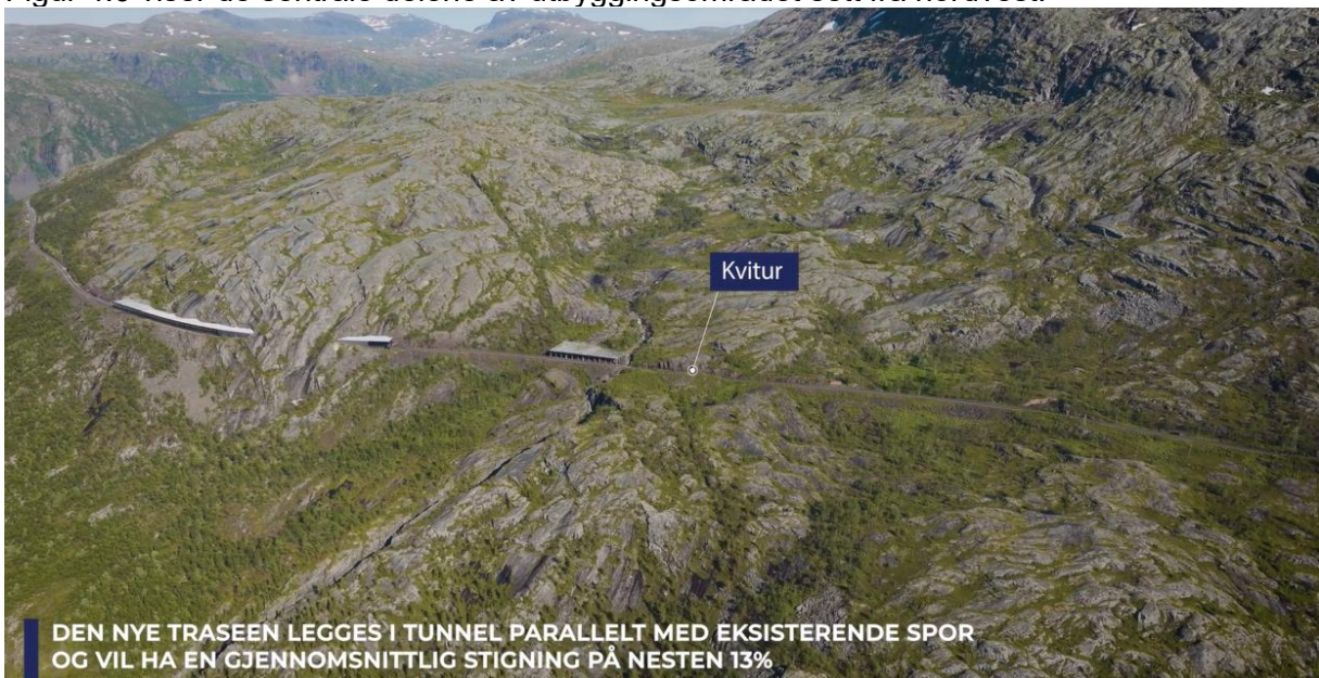
Figur 4.6. Eksisterende spor på Horisontalen (Bane NOR 2024a).
