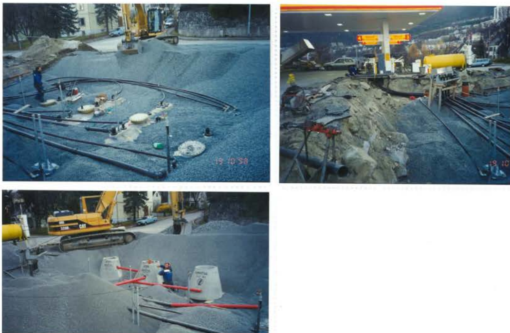
Figur 7: Bilder fra arbeidet med flytting av tankene i 1998 (mottatt av ST1). Hovedtankgropa som sees på bildene ble sprengt ut for nedsetting av tankene.
