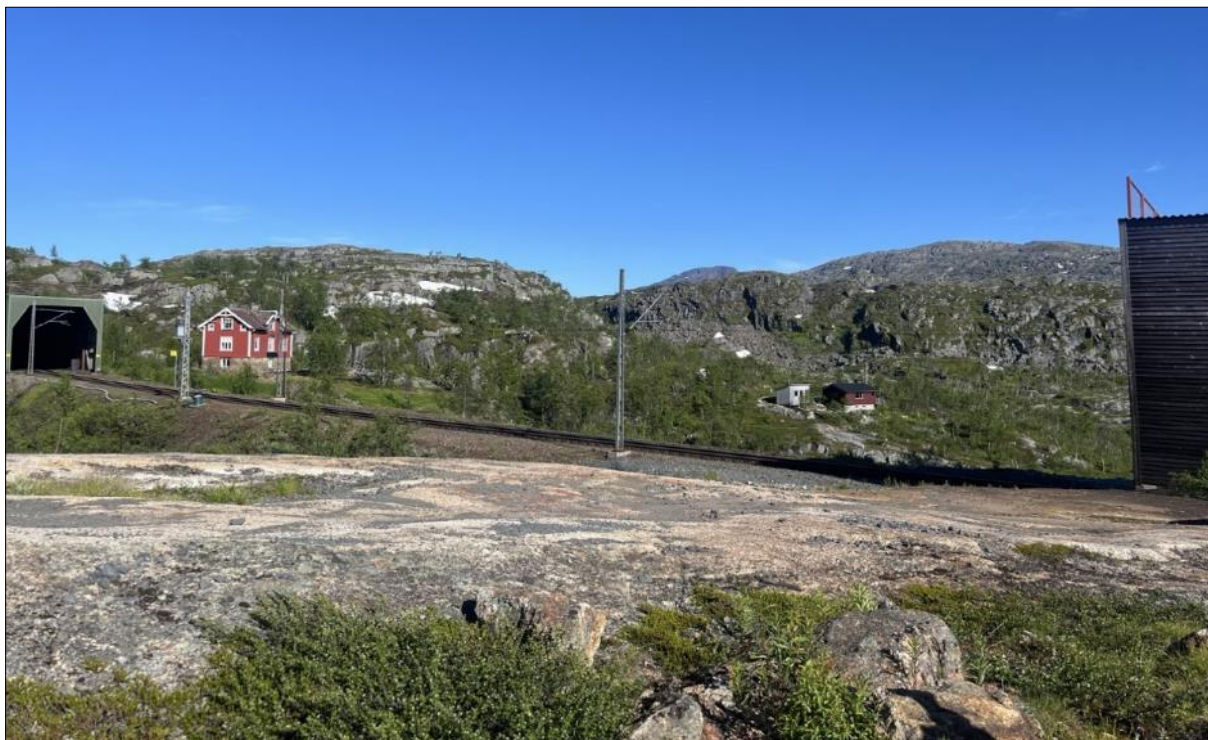
Figur 2-10: Åpningen mellom de to snøoverbyggene øst for Haugfjell. Det røde bygget i bildet er Nordstrømbrakka. Kilde: NIRAS/Sofie Bekken Romarheim.
