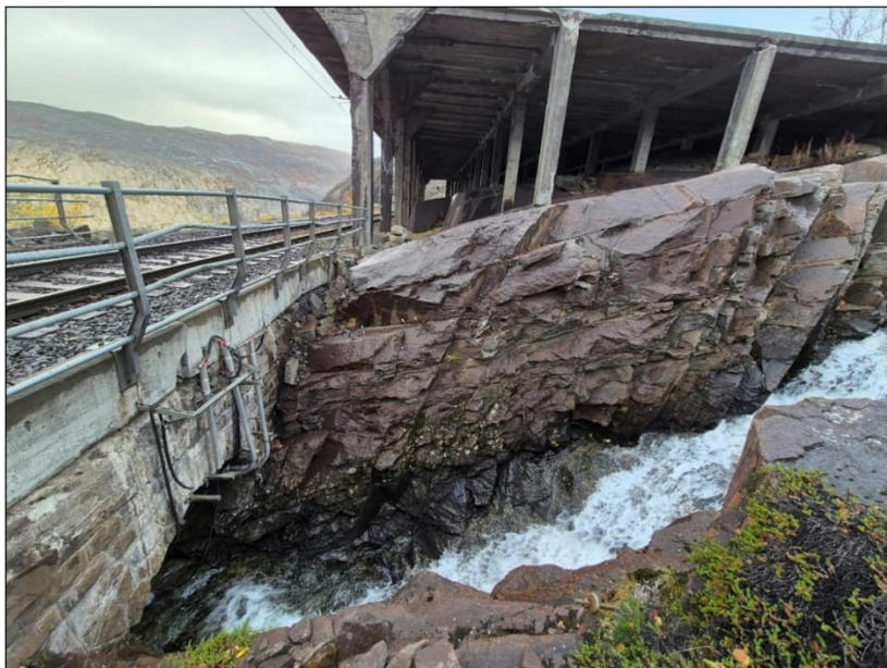
Figur 15: Viser innløpet til konstruksjonen km 24,353 (Kviturelva). Bildet er tatt fra befaring gjennomført av NIRAS 25.06.2025.
