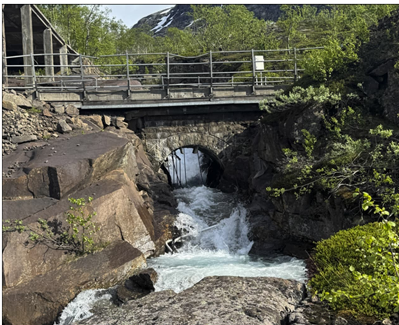
Figur 16: Viser utløpet til konstruksjonen km 24,353 (Kviturelva). Bildet er tatt fra befaring gjennomført av NIRAS 25.06.2025.
