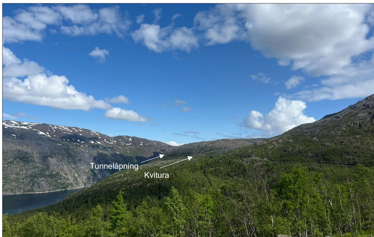
Figur 10: Bilde fra befaring 25.06.2025 tatt i retning nord-øst. Midt i bildet kan man se Kvitura og tunnelåpningen. Kilde: NIRAS/Sofie Bekken Romarheim
