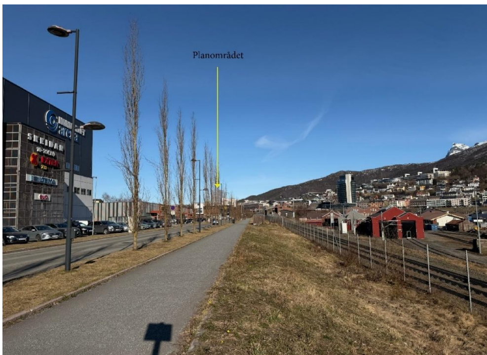
Tiltaket, sett fra Bolagata (ståsted B5)
