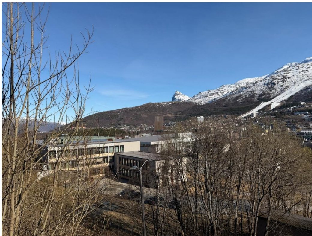
Figur 5-4. Bildet viser oversikt over delområde B. Bildet er tatt fra ståsted B2, se nærmere plassering på figur 5-3.
