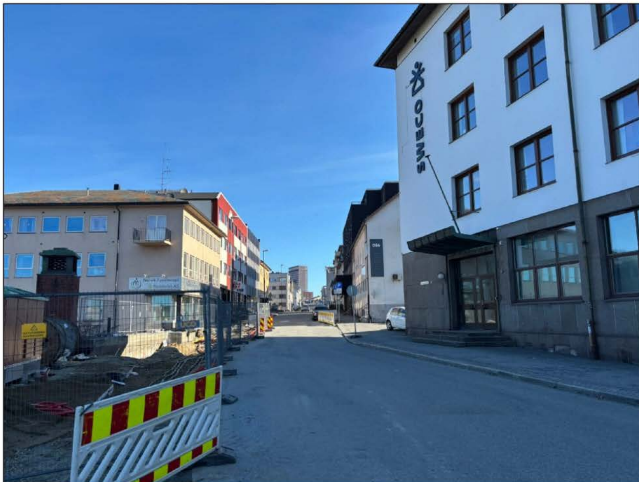
Figur 61: Tiltaket sett fra Dronningens gate innenfor kulturmiljøet K104 Narvik Sentrum BSR. Kilde: Bildet tatt av Norconsult Norge AS, modell lagt inn av Hille Melbye Arkitekter AS.
