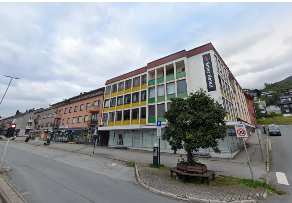
Figur 8: Eksisterende bebyggelse i Kongens gate, retning mot øst. Kilde: Google Maps.
