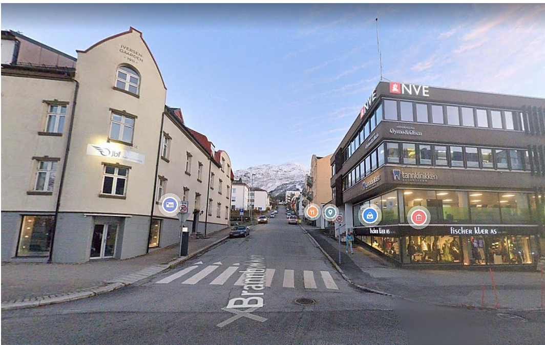
Figur 12: Eksisterende bebyggelse i Brannbakken gate, retning mot øst. Kilde: Google Maps.
