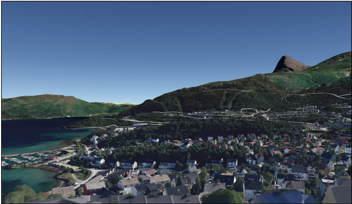
Figur 25 Visualiseringspunkt 11 - Sett fra Sykehushaugen. Dagens situasjon.
