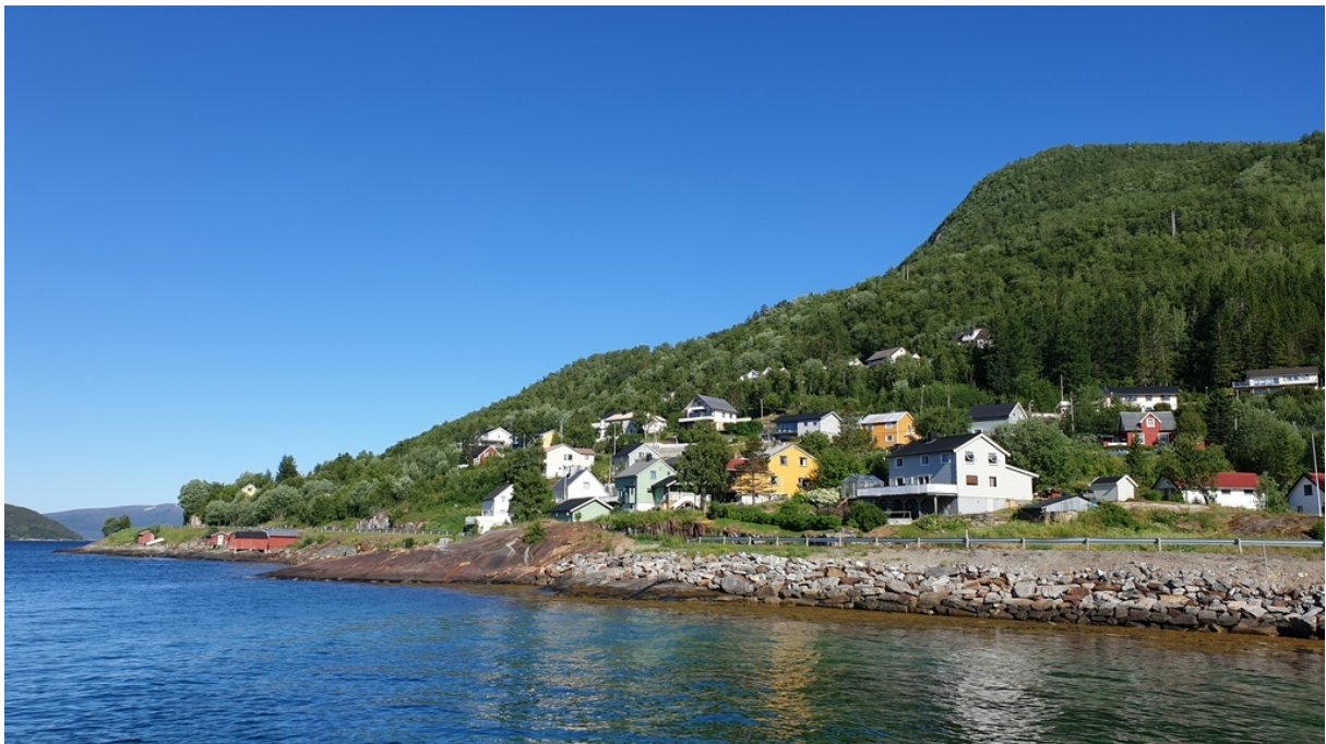
Figur 7 Boliger ovenfor rv. 7540, vest for fergeleiet. (Foto: Erik Haagensen, Statens vegvesen).
