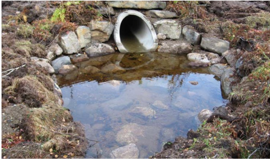
Figur 9 Steinsetting omkring stikkrenne. (Foto: Elisabet Kongsbakk, Statens vegvesen).
