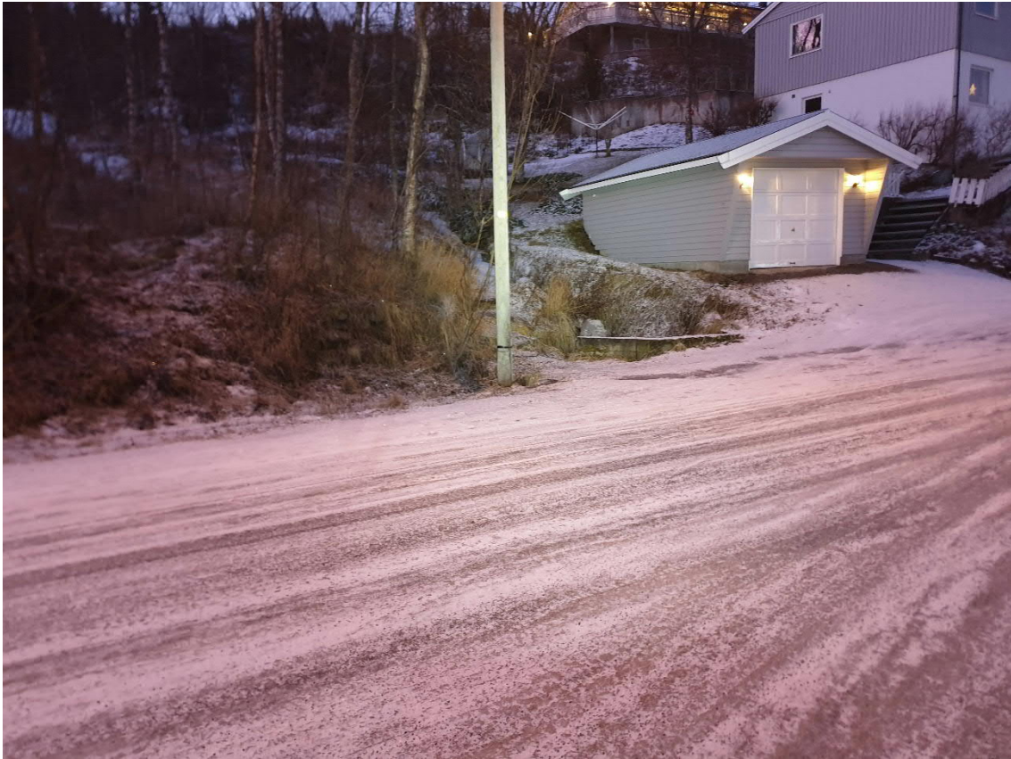
Bilde 4 , viser bekken sett motstrøms der går inn i stikkrenne nr. 1 (Ø1000mm), igjennom Åsveien.
