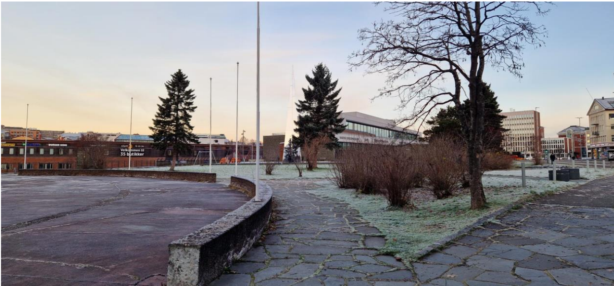
Figur 6: Parkhalltaket, retning nord. Bilde: Sweco Norge AS.
