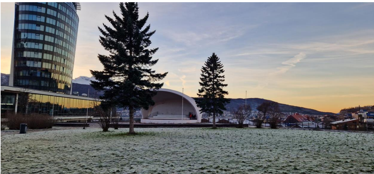
Figur 5: Sørlig del av Parkhalltaket med Haikjeften midt i bildet. Bilde: Sweco Norge AS.
