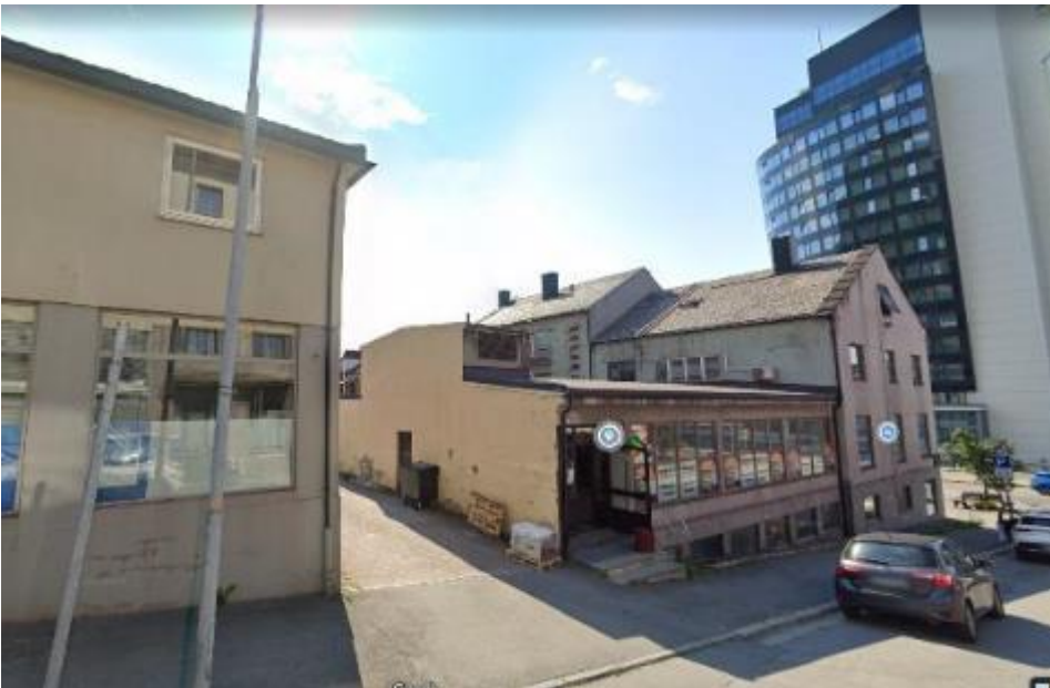
Figur 85: Kongens gate 30 sett mot nordvest. I midten ligger en lavere bakbygning i 1 etasje, og økonomigaten. Bygningen ser ut til å ha opprinnelige vinduer i teak. Bebyggelsesstrukturen i plan og bygningsvolumer representerer BSR-planen på en opprinnelig måte. Foto: Google Street View sept. 2022.
