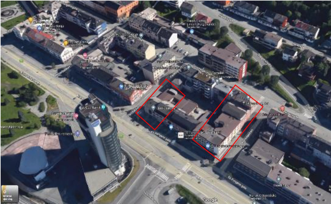
Figur 88: Bebyggelse som forutsettes revet for å legge til rette for nybyggene (ringet inn). Foto: Google Street View sept. 2022.
