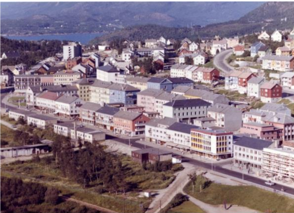
Figur 82: Nedre Oscarsborg og forretningsstrøket langs Kongens gate i 1961. De midlertidige forretningsbrakker som kom opp på vestsiden av Kongens gate etter bombingene, er ennå ikke revet. I BSR planen var området forutsatt ubebygget og lagt ut som park. Foto: Widerøe flyfoto.
