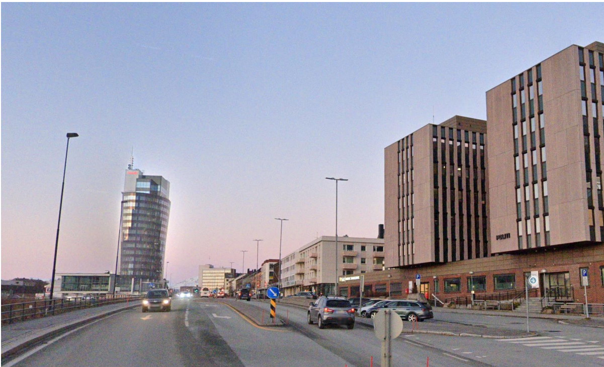
Figur 14: Bilde er tatt fra sørlige del av Kongensgate mot nord. Til høyre i bildet kan man se «Post- og politibygg» som er 6-7 etasjer, høyde på bygge fra gateplan er ca. 26.5 meter. Scandic hotell på 18 etasjer og en høyde fra gateplan på ca. 55 meter ligger til venstre i bildet. Rett frem kan man se Narvik rådhus på 8-9 etasjer og en høyde fra gateplan på ca. 32 meter.
