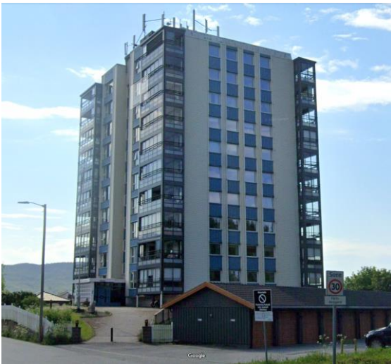
Figur 21: Bilde til høyre viser punktveien 1 på Framnes som er 10 etasjer og har en høyde fra bakkeplan på ca. 34 meter.
