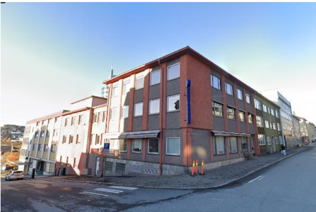
Figur 87: Dronningens gate 27 sett mot nordvest. Bygningen har valmet tak. 1. etasje var opprinnelig trukket noe inn, men er nå bygget igjen. I kvartalet er bebyggelsen holdt i 3-4 etasjer, og nedtrappet etter terrenget. Foto: Google Street View sept. 2022.
