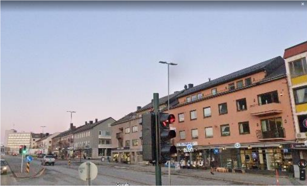
Figur 81: Gjenreisningsbebyggelse langs Kongens gate, sett mot nordøst. Den karakteristiske, nøkterne bebyggelsen med avlange murbygninger i 3 etasjer, lik gesimshøyde og slake saltak gir et enhetlig gatebilde. Åpne forretningsfasader på gateplan bidrar også. Rådhuset i enden er oppført som et høyere bygg. Foto: Google Street View sept. 2022.
