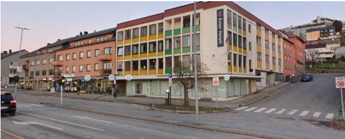
Figur 86: Kongens gate 26 på hjørnet, sett mot nordøst, med tidstypiske rasterfasader og svensketak. Hotellet er bygget i henhold til BSR bebyggelsesplan, med 4 etasjer på hjørnene i hotellkvartalet/rundt Bankgaten. Gjenreisningsarkitekturen i Kongens gate 28 (rosa bygning i midten) og Kongens gate 30 (helt til venstre) har nøkterne fasader med pusset mur og små balkonger som eneste fasadeutstyr. Foto: Google Street View sept. 2022.
