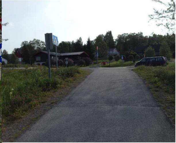
Bilde 4 – Eksisterende G-/Sykkelvei og gangfelt over E6. Uoversiktlig og stor høydeforskjell som gjør at gående kommer overraskende fort innpå E6.
