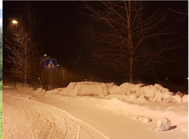
Bilde 8 – viser vittersituasjon av bilde 3 over. Som det fremgår er krysset uoveriktlig og uheldig snødeponering forsterker dette. Vintern 2016 ble gangfelt skiltet kjørt ned av bil. Ikke lenge før noen blir påkjørt her.
