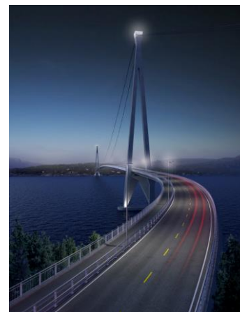
Hålogalandsbrua 1533 meter ferdigstilles i 2017.
