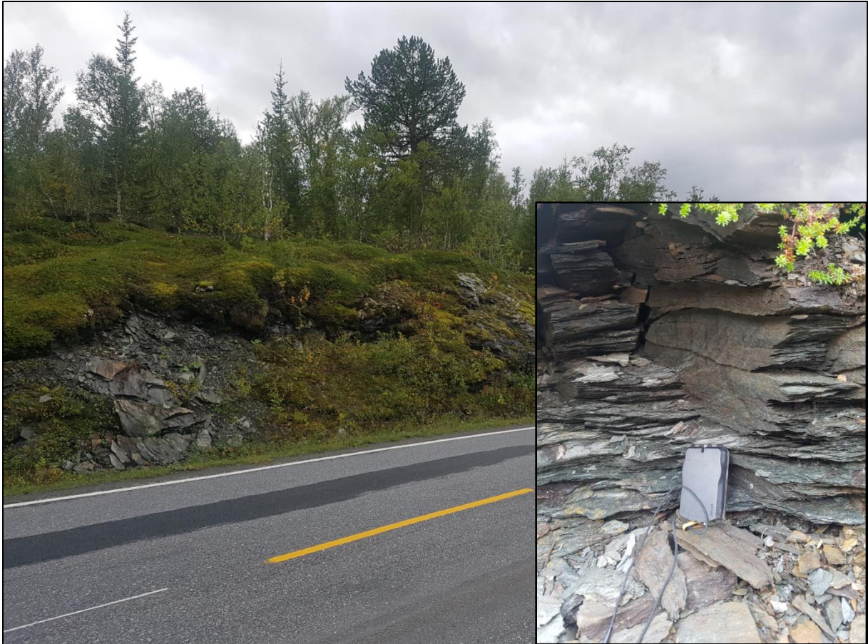
Foto 2: Ekisterende bergskjæring ved Trollvatn med strekt forvitret og lagdelt (skifrig) fyllitt/glimmerskifer.
