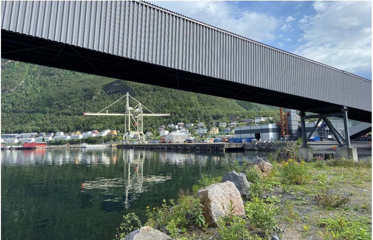
Figur 30: Dagens situasjon under samlebandet til bulkterminalen.
