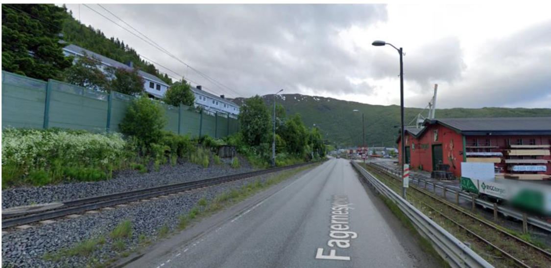
Figur 2 Fagernesveien, opp ifra og ned: Norra delen retning syd med fortau, midt delen retning nord med gang- og sykkelvei avskilt, sørsiden av strekningen retning sør mellom to jernbanespor med boliggate parallelt
