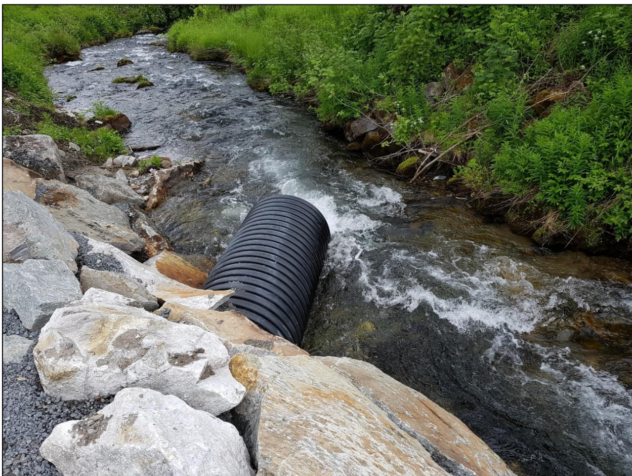
Bilde 11.1: Overvannsledning med utløp i Taraldvikelva.
