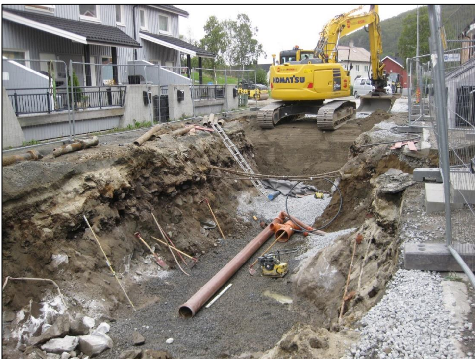
Bilde 10.1: Sanering og separering avløpsledninger i Falkbergets vei.
