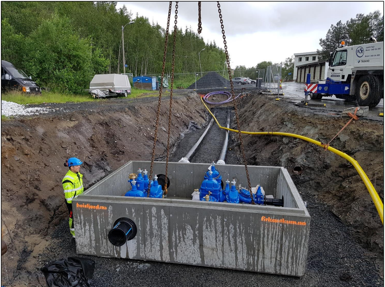
Bilde 8.1: Sanering av vannledninger i Fosseveien.
