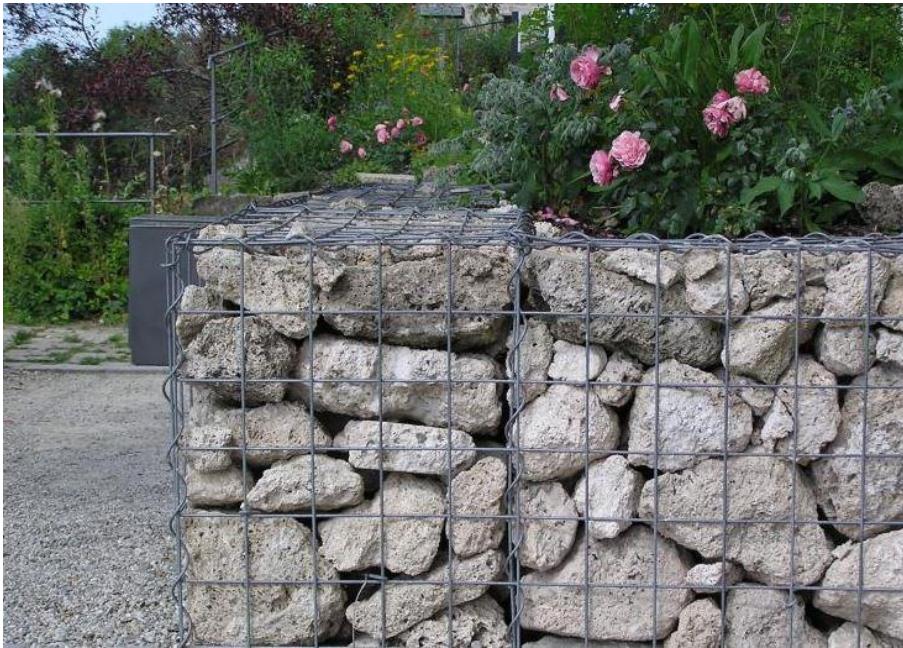
Bilde 7- Eksempel gabion-mur
