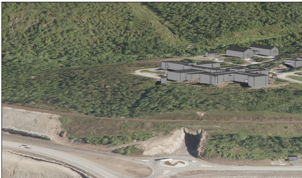
Figur 5-2: Planområdet sett fra nordvest. Påhugg til den nye tunnelen fra E6 vises midt på bildet. Furumoen sykehjem vises til høyre i bildet. Kilde: Nordlandsatlas i 3D.
