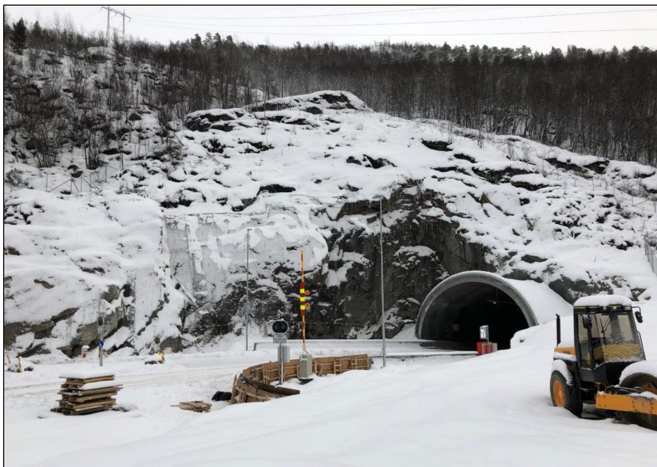
Figur 5-10: Tunnelpåhugg øst. Bilde fra befarig 5. november 2019.
