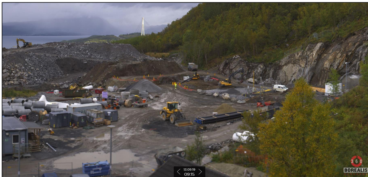
Figur 5-5: Utsnitt som viser planert område ved tunnelpåhugg og massedeponi. Bilde tatt 13.09.2019 kl. 09:15. Kilde: Borealis Panorama 360 UNN.
