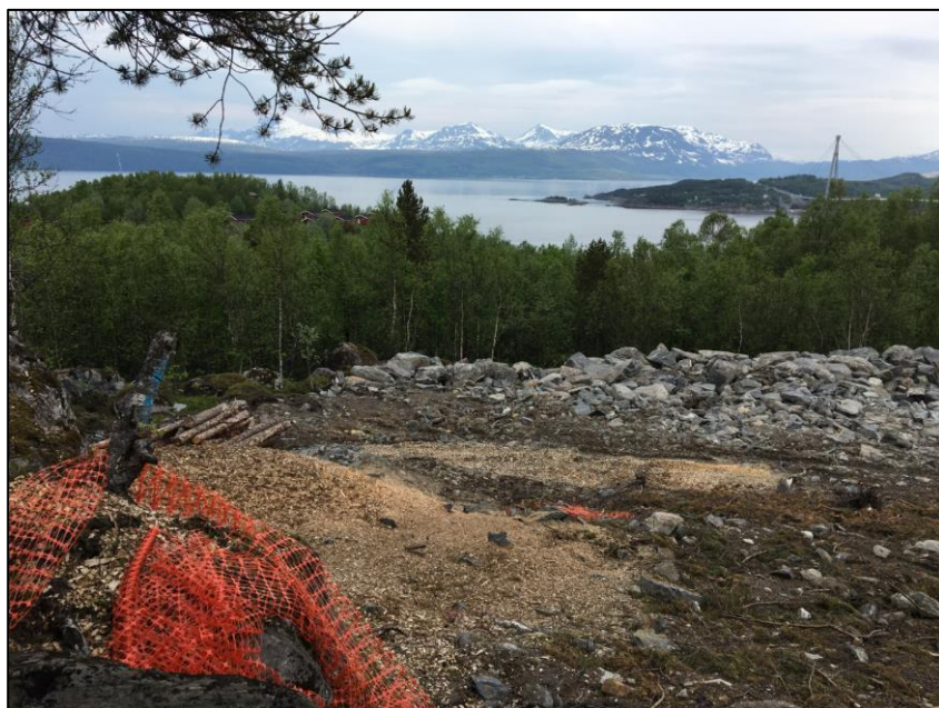
Figur 5-9: Utsikt fra Furumoen mot nord. På bildet ser vi bl.a. deler av Hålogalandsbrua. Bilde fra befaring 7. juni 2019.
