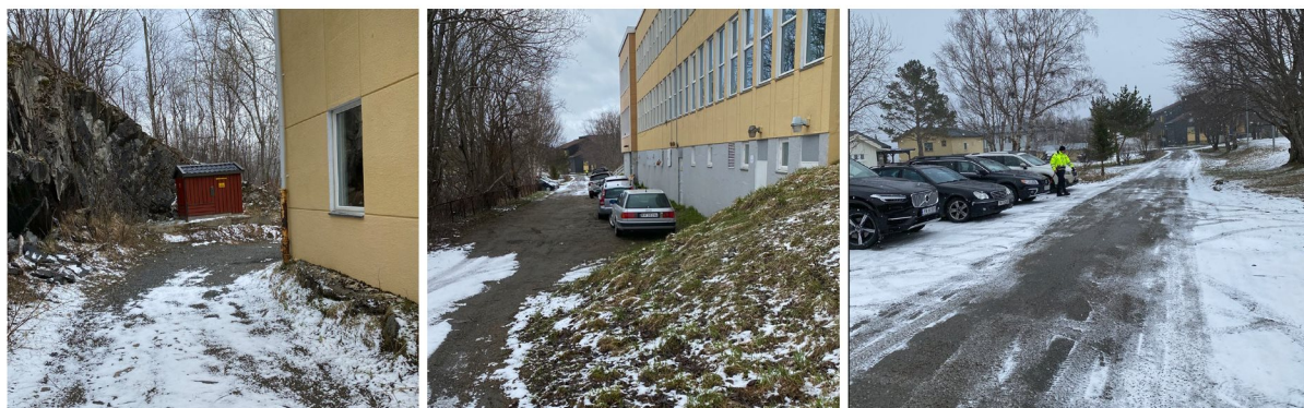
Figur 6 Parkering og trafø bak dagens skolebygg og langs skolebygg i nordøst (i midten) og langs adkomstvei (t.h.)
