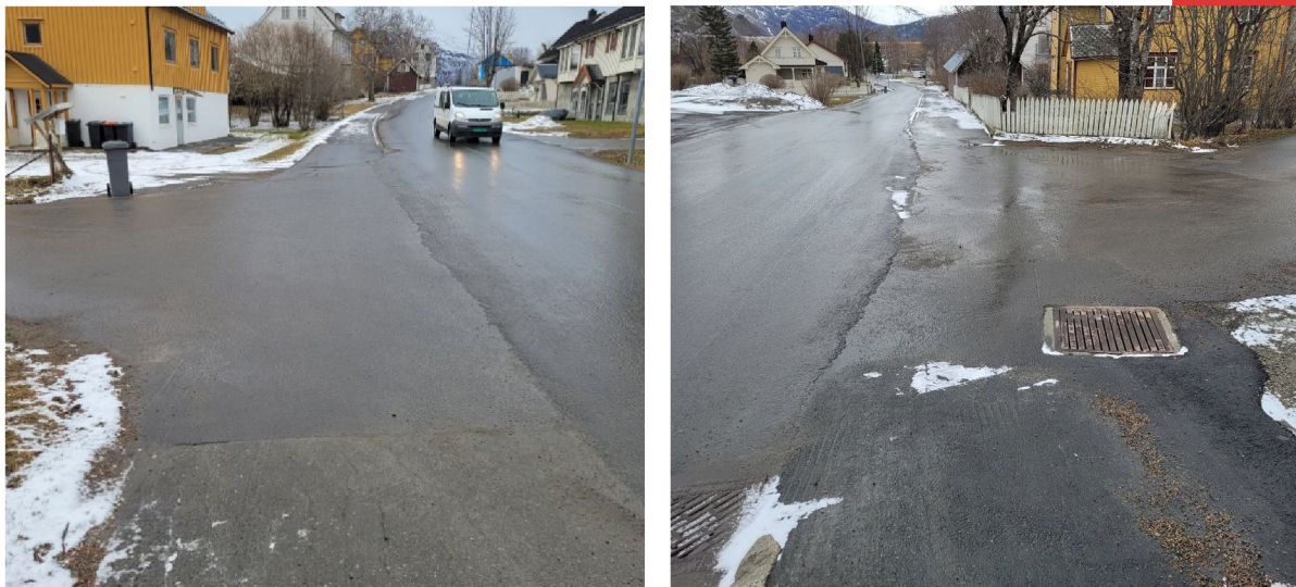
Figur 5 Fortau i kryss Hovedveien x Prestegårdsveien og i kryss Hovedveien x Nergårdsveien (manglende og udefinerte fortausavslutninger) t.h.
