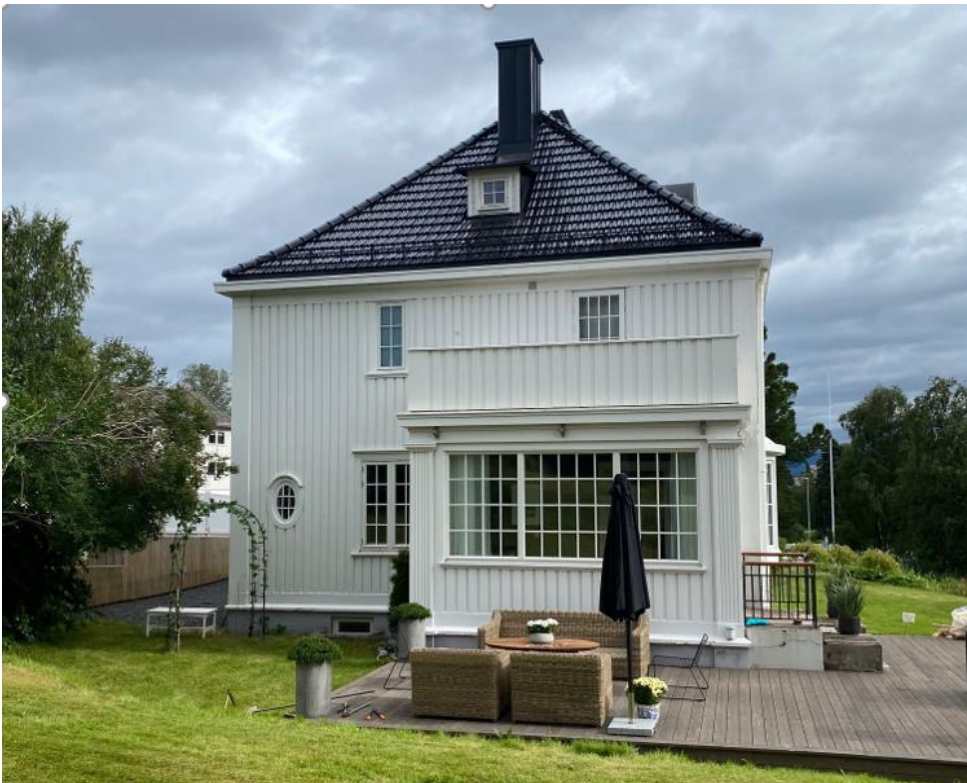
Figur 25: Eksisterende bygg i planområdet, retning øst. Bilde: Thomas Nystad.
