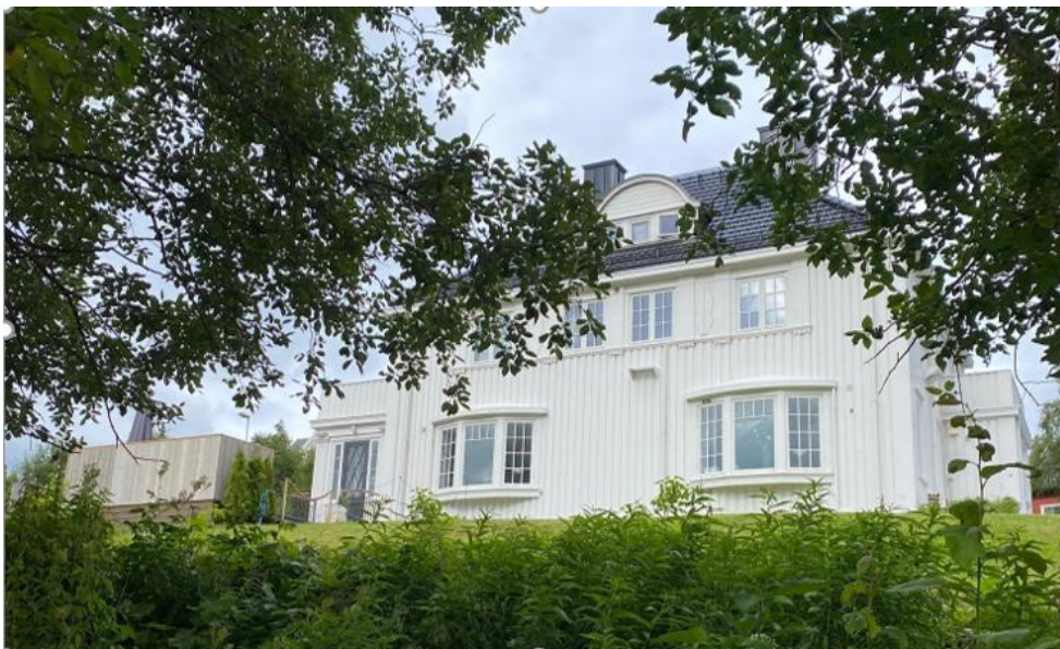
Figur 26: Eksisterende bygg i planområdet, retning nord. Bilde: Thomas Nystad.
