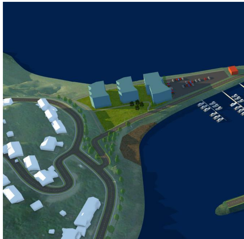
Sett fra sør-øst
