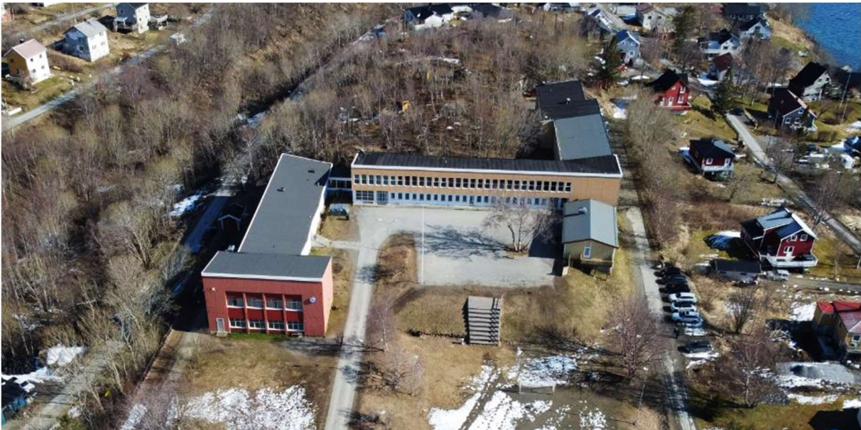
Figur 1: Dronebilde av dagens skole
