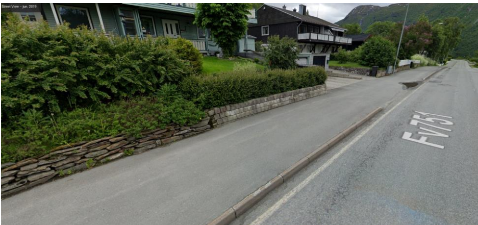
Figur 4 Fortau på østsiden av fv. 7570. Kilde: https://www.google.no/maps
