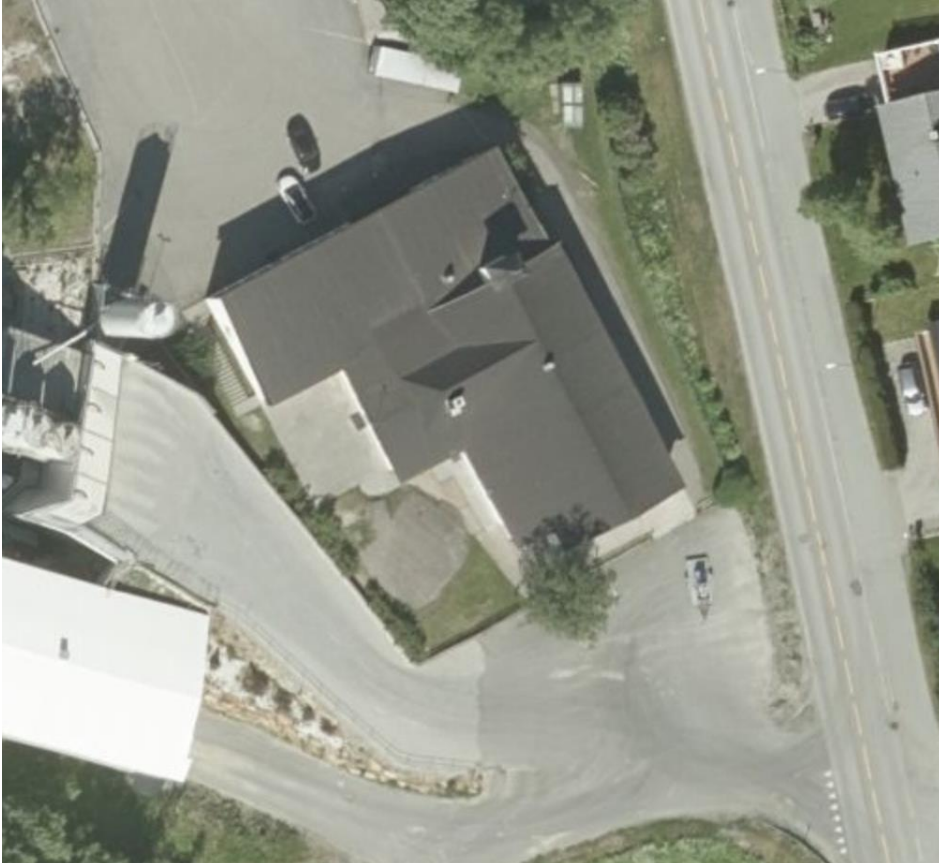
Figur 2 Bildet viser bygg plassert sør på tomten. Mot nord er det ett stort parkeringsareal. Mellom bygget og Lauvveien i sør er det ett lite parkeringsareal og adkomst til Narvik betongstasjon fra fv. 7570. Kilde: https://tor.narvik.kommune
