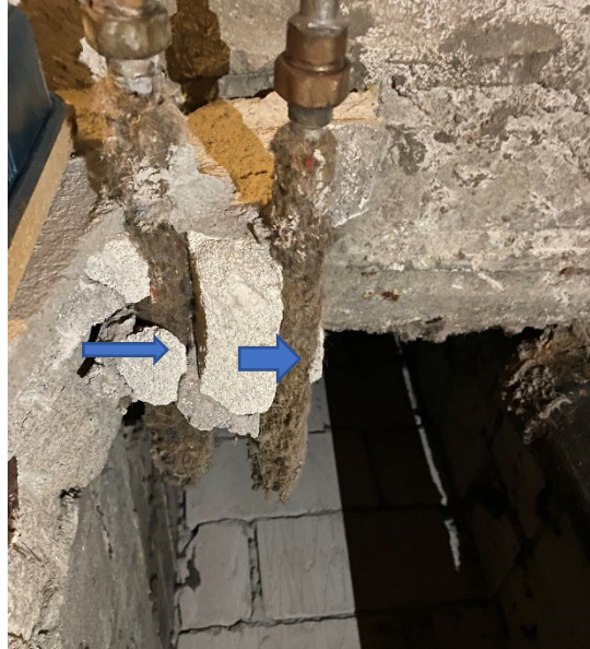
Plassering: Forrom til rom under svømmebasseng, spesialfløya Materialtype: Rørgjennomføring med synlig tettemateriale rundt. Antall: 3 stk.
