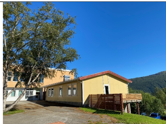
Plassering: Administrasjonsfløy, veranda, gelender og stolper Materialtype: Trykkimpregnert trevirke med ukjent byggeår.
