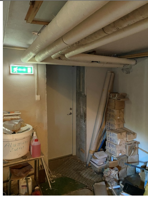
Plassering: Spesialfløya, forrom til rom under basseng Materialtype: Eldre isolerte rør
