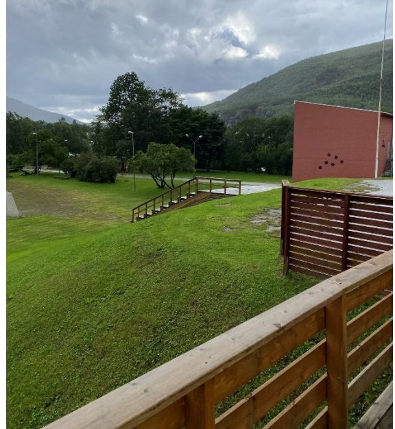
Plassering: Utendørs Materialtype: Trykkimpregnert trevirke med ukjent byggeår.
