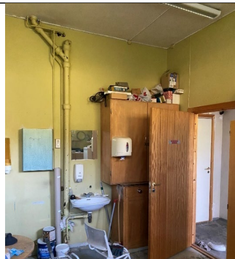
Plassering: Spesialfløy, vaktmesterkontor Materialtype: Soilrør
