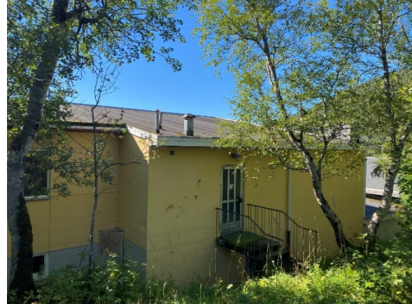
Plassering: Tak på deler av nyfløya Materialtype: Asfaltbasert takpapp Verdi/antall: Hele takarealet
