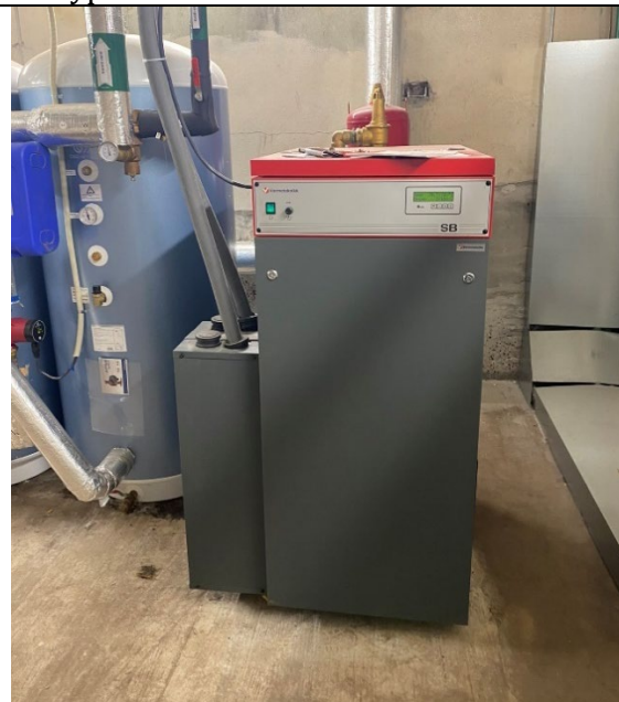
Plassering: Spesialfløy, fyrrom EE-type: EL-kjel
