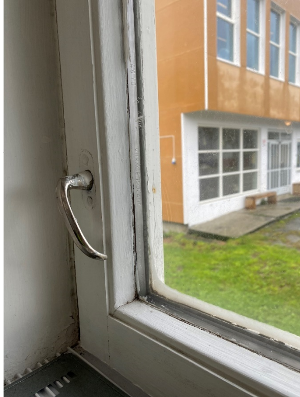
Plassering: Spesialfløy Observasjon: Vitrage isolant Thermopane
