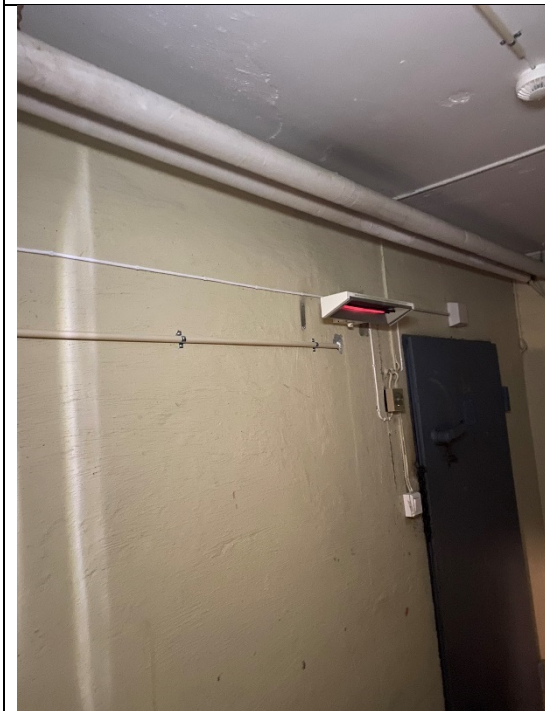
Plassering: Nyfløya, sokkel, tilfluktsrom Materialtype: Eldre isolerte rør Antall: 2 synlige rørføringer
