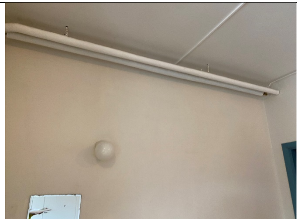
Plassering: Gammelfløya, toalett Materialtype: Eldre isolerte rør
