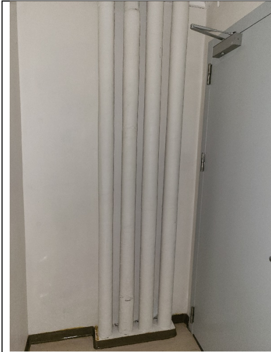
Plassering: Spesialfløya, Garderobe Materialtype: Eldre isolerte rør Antall: 4 stk.
