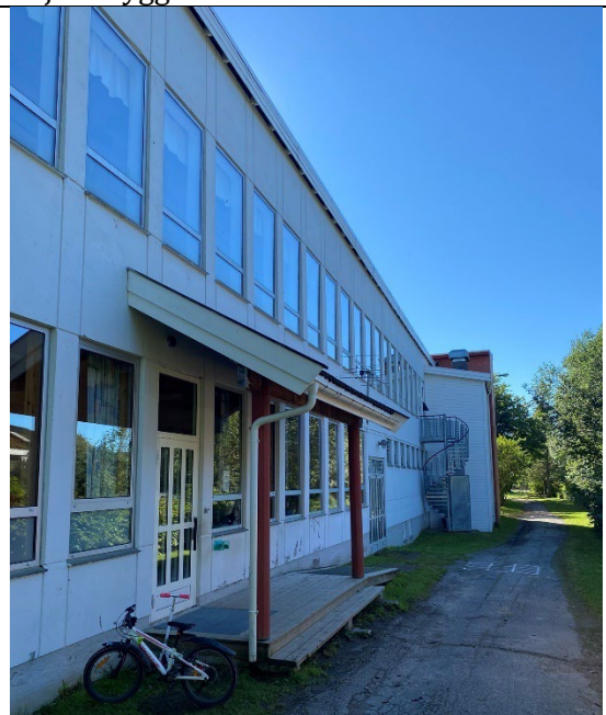
Plassering: Gammelfløya/spesialfløya Materialtype: Trykkimpregnert trevirke med ukjent byggeår.
