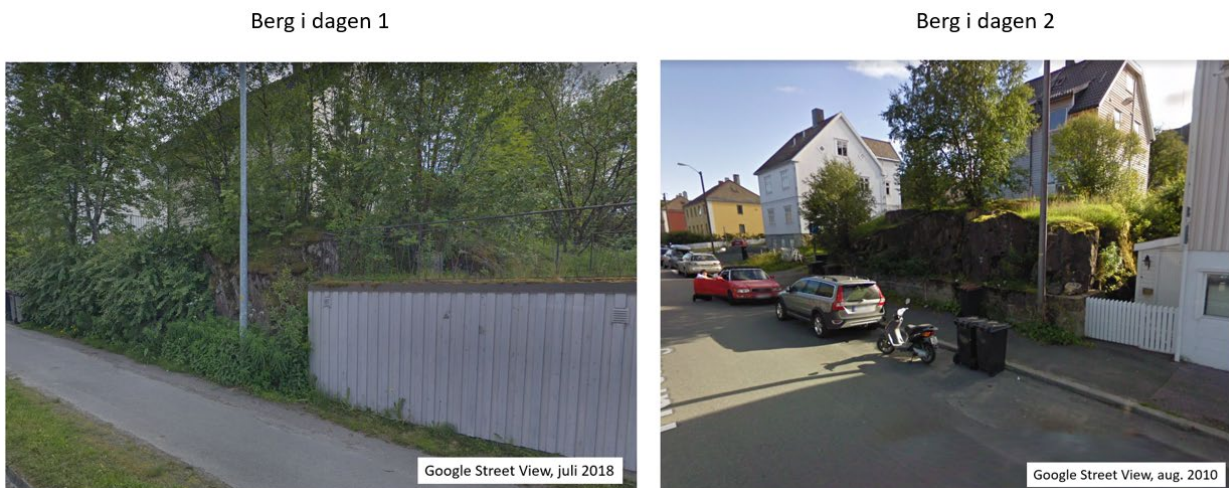
Figur 5 Bilder fra Google Street View med berg i dagen.
