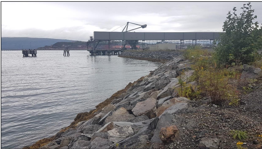
Figur 33: Ytre del av utfyllingene langs vestsiden av Skarveneset i dag (2021). Fyllingsfronten mot sjøen har fått en god linjeføring, og med plastringer av stor stein. Nye utfyllinger mot Beisfjorden og i Narvikbukta bør få samme behandling og ddt bør plantes en trerekke, evt. med busker langs hele sjøfronten her
