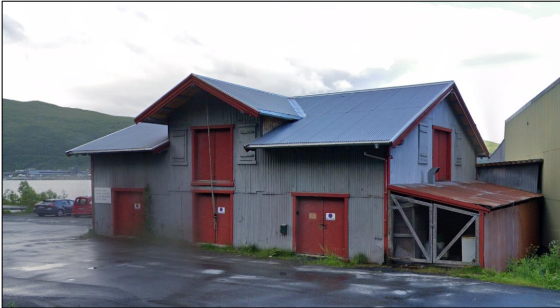
Figur 18: Fagernesveien 16 i dag. Huset ble oppført i 1916 og var tidligere lager for havnevesenet. I nyere tid har huset vært disponert av Narvik kystlag. Huset stod tidligere på tomten til Havnens Hus, og ble flyttet til nåværende tomt i 1937.
