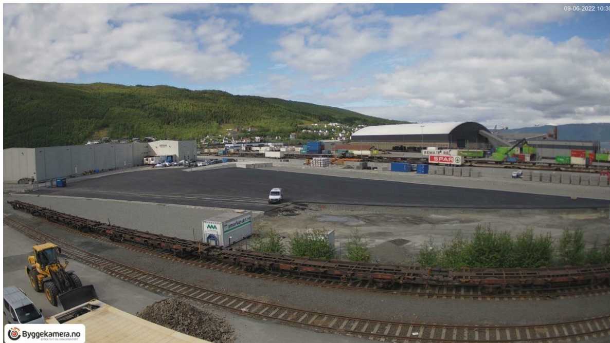
Figur 23: Terminalområdet er under utbygging, og flere bygg er nylig revet. Kilde: Bane NOR.
