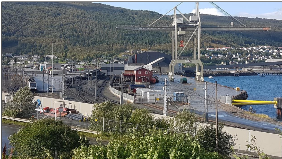
Figur 9: Søndre del av planområdet med terminal i 2021. Området domineres av jernbaneanlegg, arealer for containerhåndtering og noe bebyggelse.
