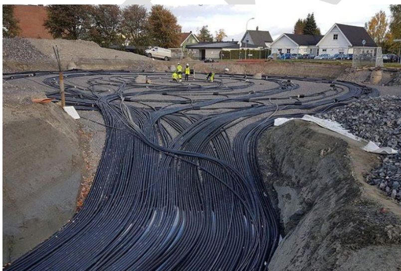
Figur 4.3 GeoTermos ved Fjell skole i Drammen består av 100 seriekoblede brønner.
