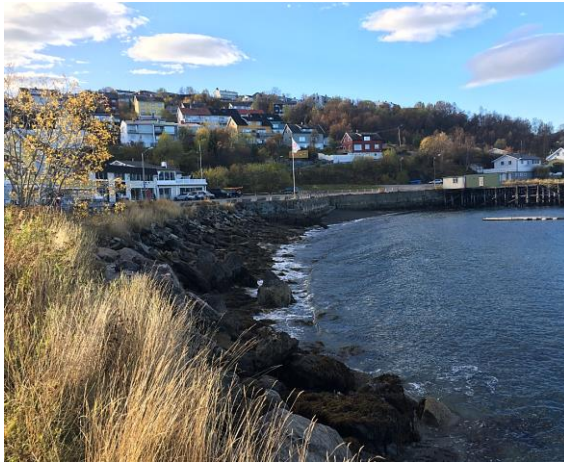
Utfylt strandsone ved eksisterende naust i øst.
